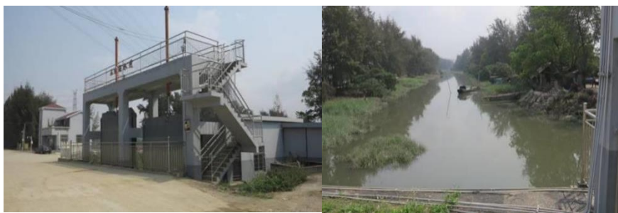
图 5.1-2 石围涌（出海口处）现状照片
