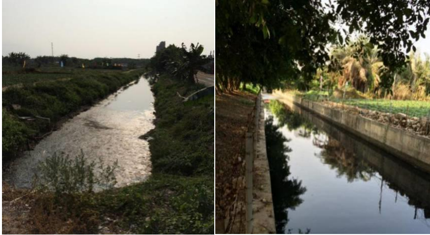
图 5.1 -3 石围涌（民主大道处）河道现状照片
