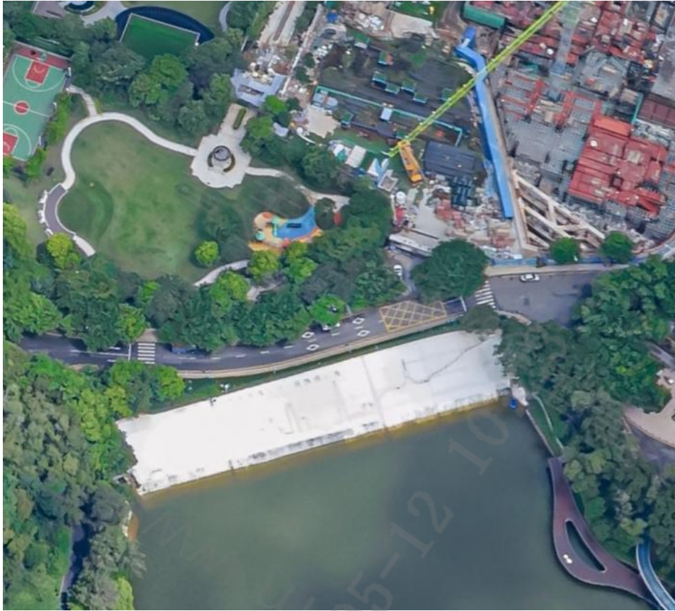
图 1.2-3 银湖水库大坝航拍图
