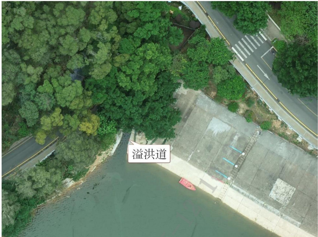
图 1.2-4 银湖水库溢洪道航拍图
