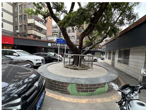
树池内硬化铺装
