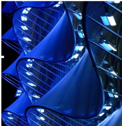
结构照明 STRUCTURE LIGHTING
