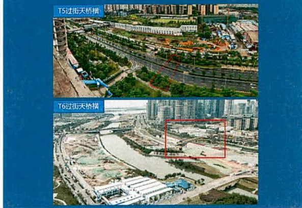
2. 过街天桥一期—T5、T6建设项目 (现场照片)
