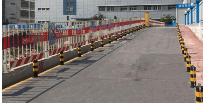
基坑周边钢板铺设硬地化示意图
