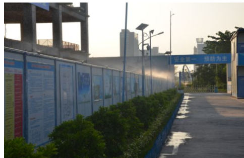
施工道路喷雾降尘
