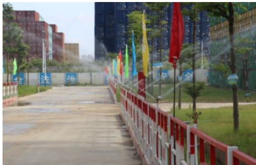
围墙喷雾降尘、绿化浇灌
