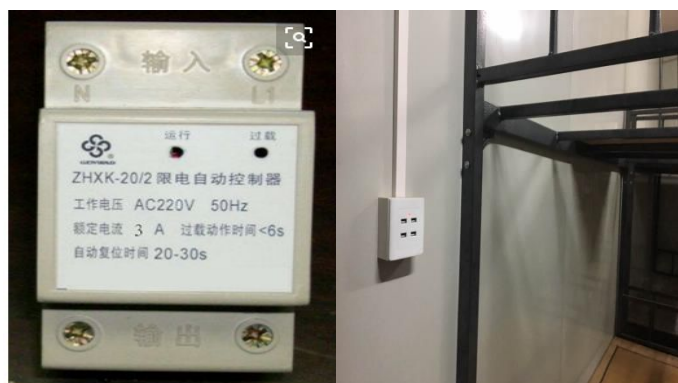
宿舍限流器、USB 接口安装示意图
