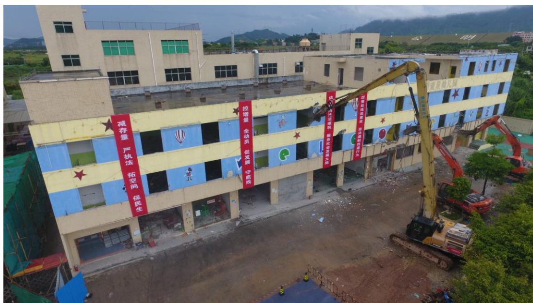
光明街道迳口社区富宝工业园违建拆除现场
